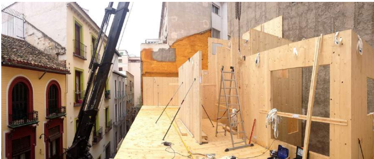
Detalle de obra del edificio eco-pasivo de madera en pleno casco histórico | Bonsai Arquitectos
