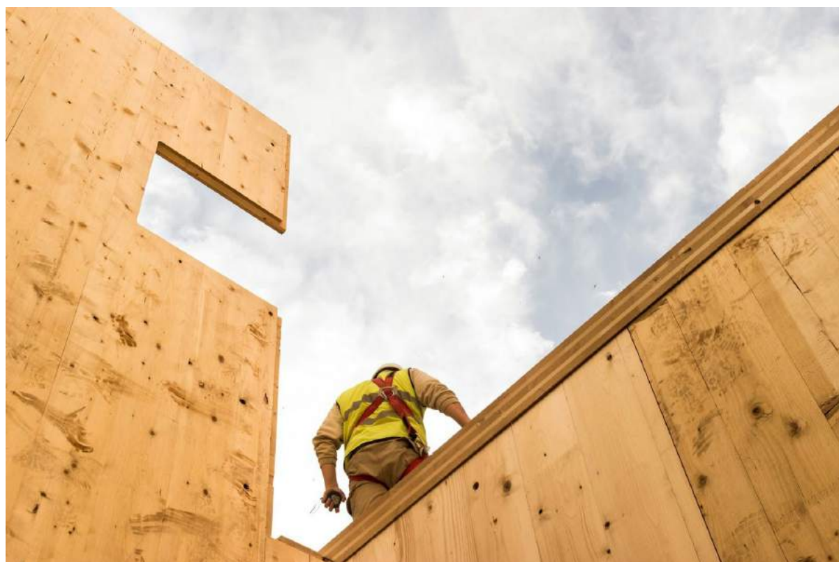
Estructura de madera contralaminada del nuevo edificio eco-pasivo en Granada /Adam Toth
